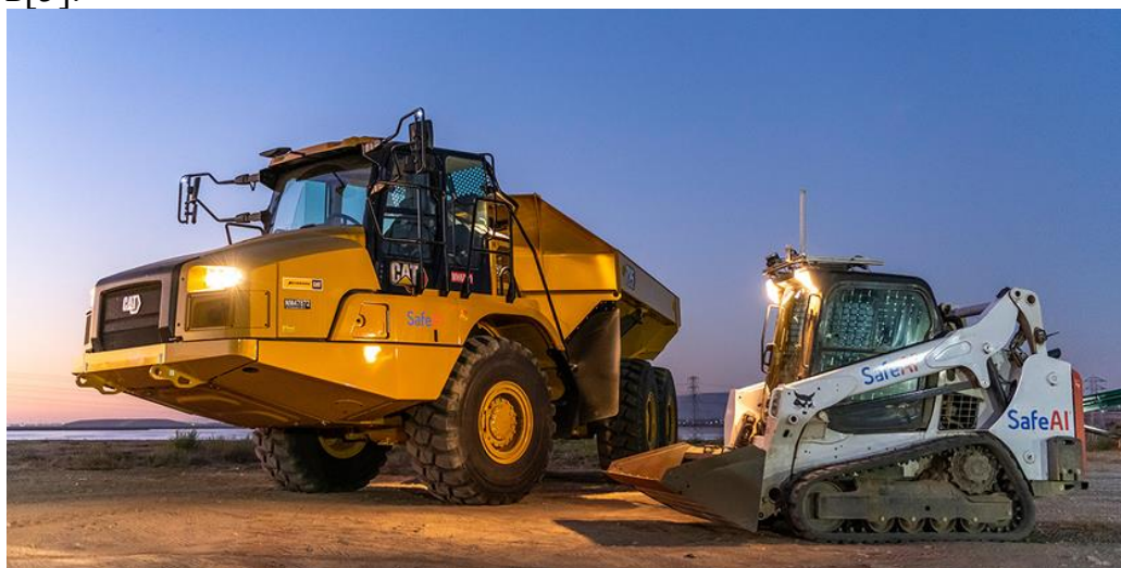
Рисунок 2. Разработана первая в мире строительная площадка, где работают только роботы. [5]
