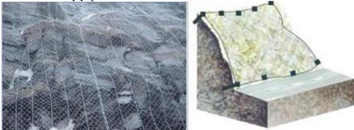
Рисунок 3 - Устройство противокаменной защиты откоса
